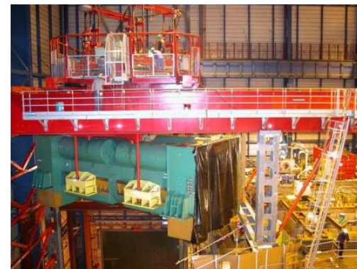
Réalisation de la rotation du stator en tranche 2
